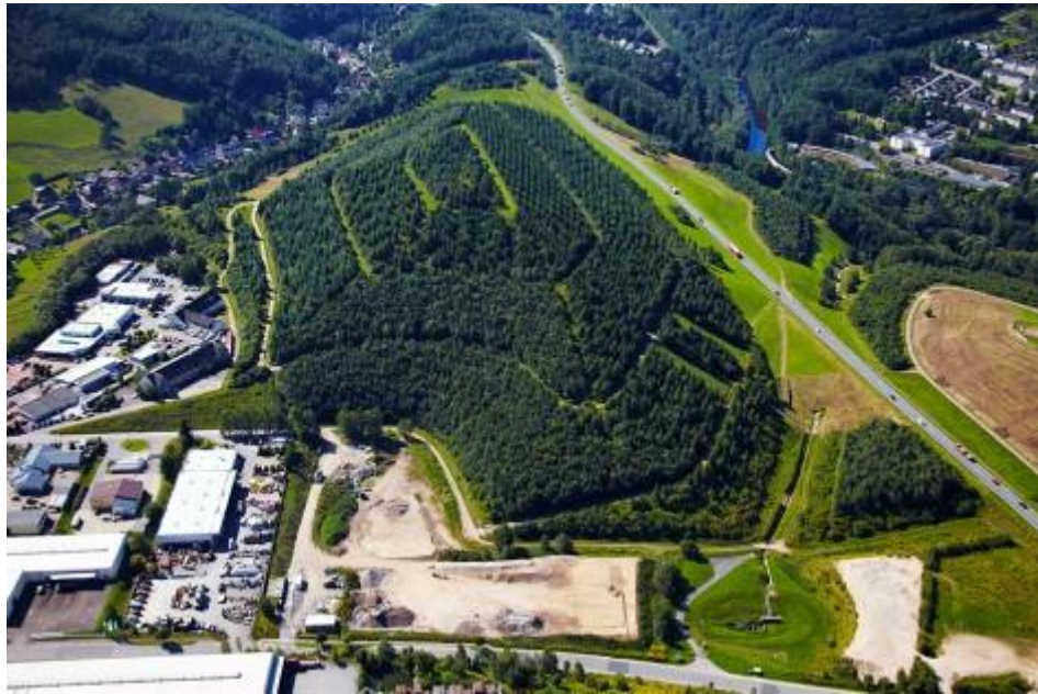
Foto: Halde 366 Aue – Bad Schlema Quelle: WISMUT GmbH
