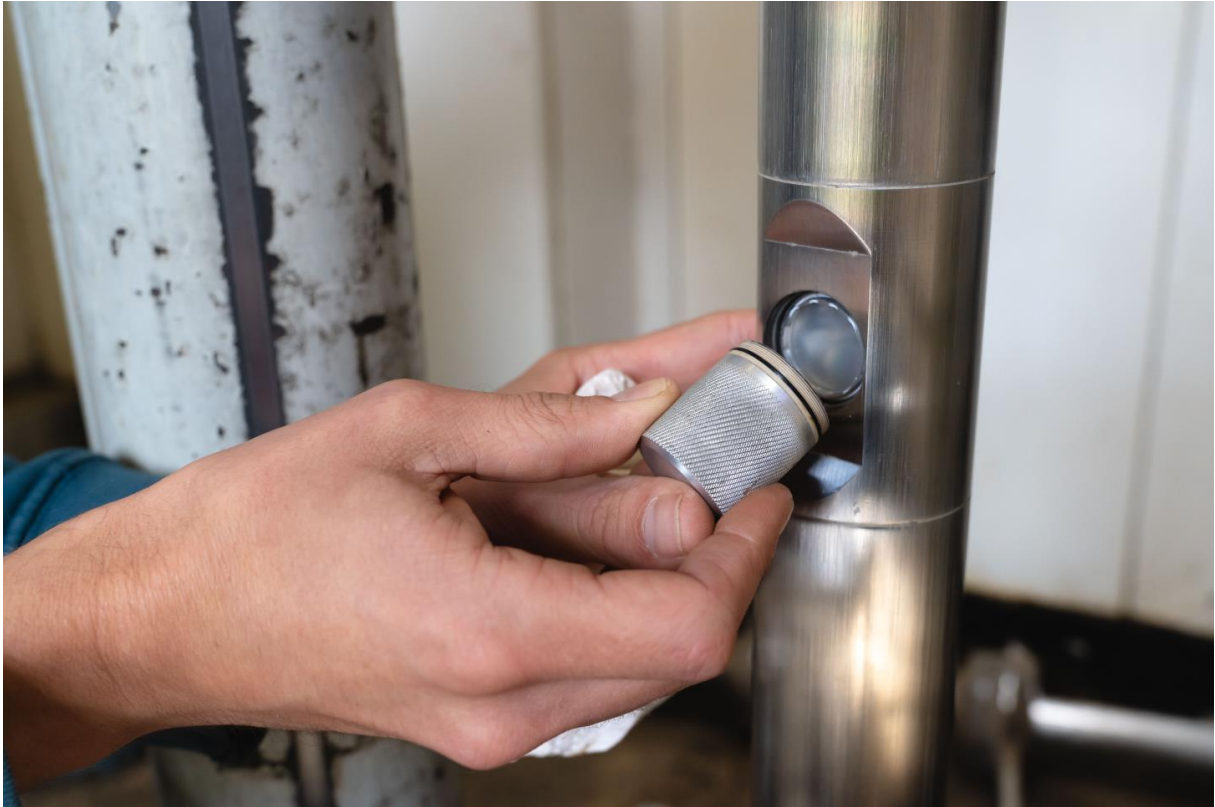
Abbildung 2: Montage des Messfensters
